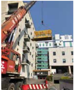
設備吊掛作業
