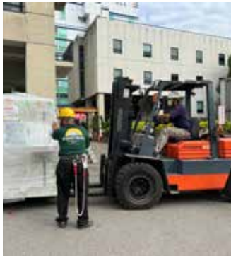
設備搬運作業
