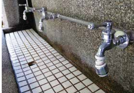
進行洗手台節水器安裝，落實節約用水。
